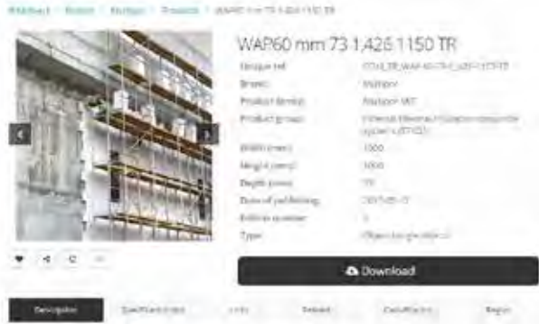
Resim 1: 60 mm kalınlığındaki Multipor Isı Yalıtım Levhası ile mantolama uygulaması
