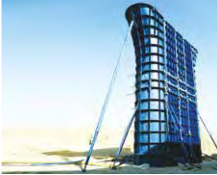
Çandabil Köprüsü / Türkmenistan
