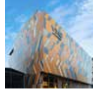
54 İrme Elektrik Headquarters'ta XL Mimarlık+Mühendislik İmzası
