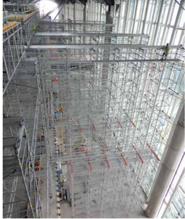
DöŖeme yırtıkları için H=30m yüksekliğinde iskele kurulması:
