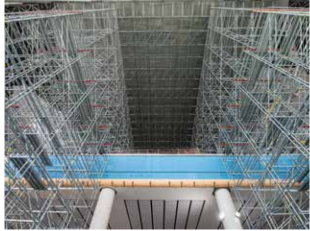
Sistemin terminalin dış bölgesinde asma tavan işlerinde kullanılması:
