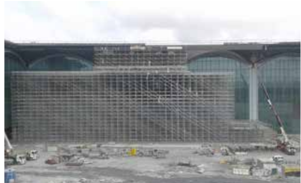
Sistemin terminalin dış bölgesinde asma tavan işlerinde kullanılması:
