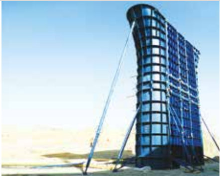
Çandabil Köprüsü / Türkmenistan
