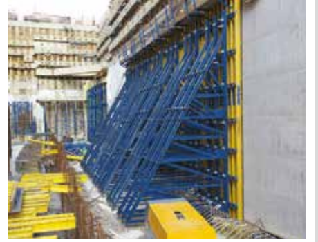
Üsküdar-Ümraniye-Çekmeköy Metrosu / İstanbul
