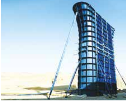
Çandabil Köprüsü / Türkmenistan
