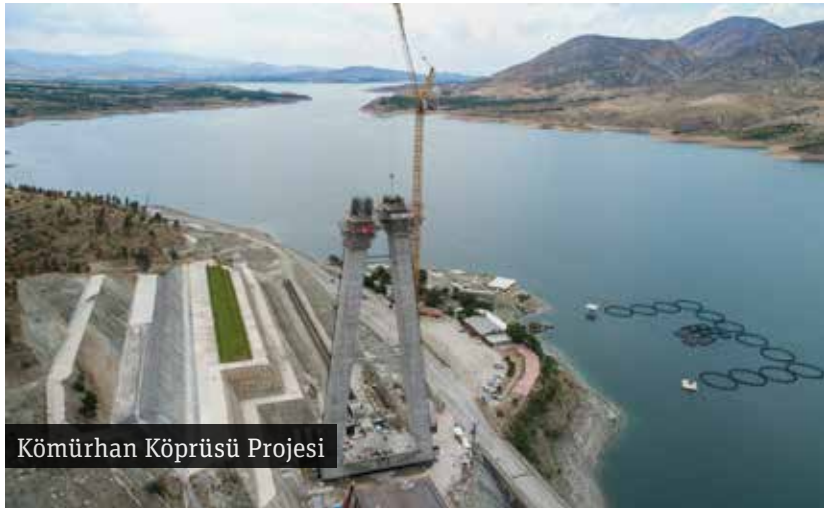
Kömürhan Köprüsü Projesi
