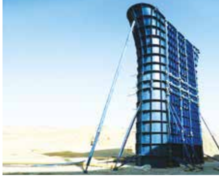
Çandabil Köprüsü / Türkmenistan
